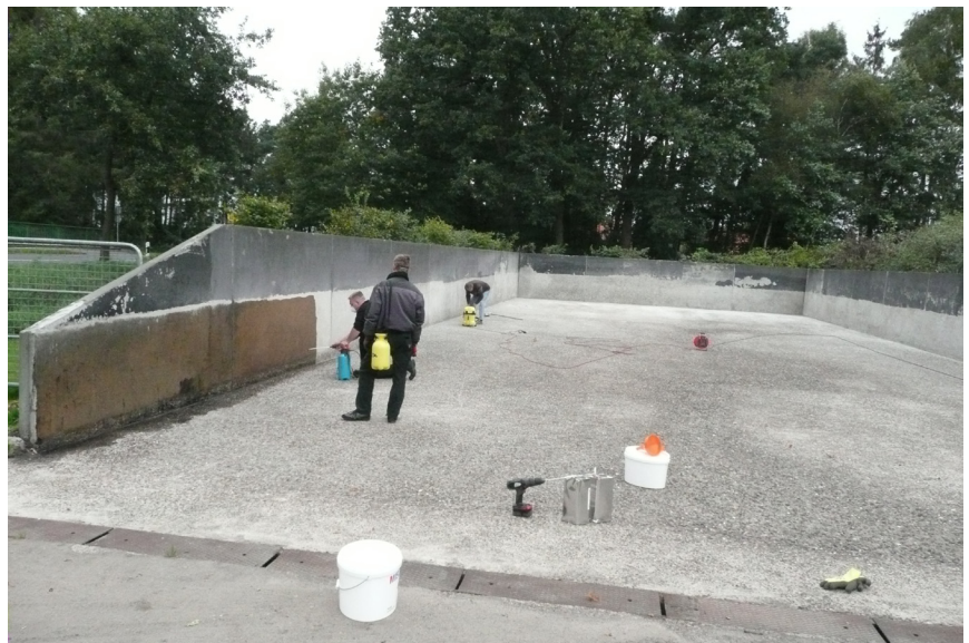
Imprägnierung einer Silageplatte mit Plastadur P
