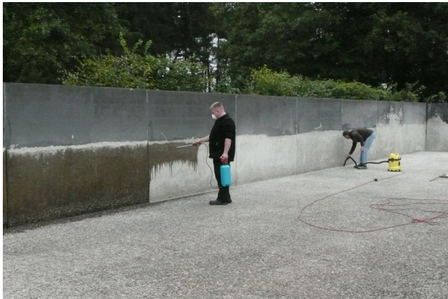
Imprägnierung einer Silageplatte mit Plastadur P
