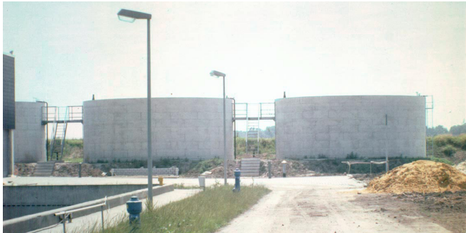
Kläranlage Dorsten, Schutz und Abdichtung der Klärschlamm-Silos durch PlastaDur-P
